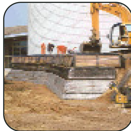
Emmen, Niederlande: Steilwand unter Verwendung von Enkagrid PRO and Enkamat 7210
