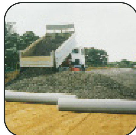
Auckland, Neuseeland: Herstellung einer Baustrasse mit Enkagrid TRC 30
