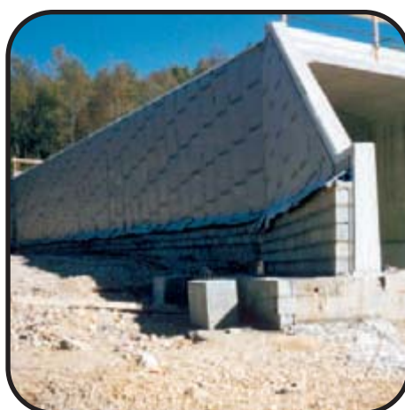
Frankreich Tunnel in offener Bauweise
