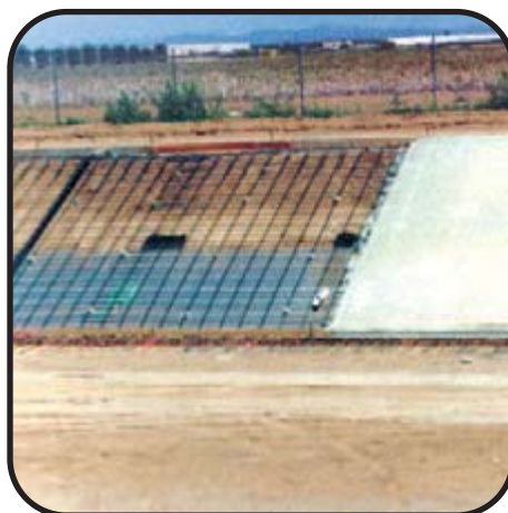
Phoenix, Arizona Wasserdränschicht
