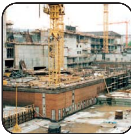
Stuttgart, Deutschland Verlorene Schalung
