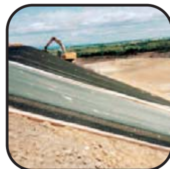
Béziers, Frankreich Kombinierte Drän- und Erosionsschutzschicht
