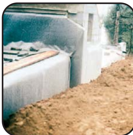
Tübingen, Deutschland Wand eines Tiefgeschosses
