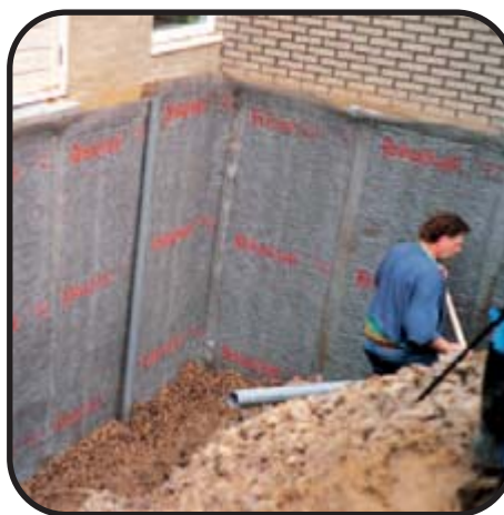
Haren, Niederlande Wand eines Tiefgeschosses
