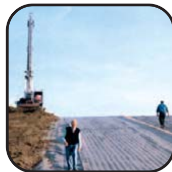
Landgraaf, Niederlande Wasserdränung einer Mülldeponie
