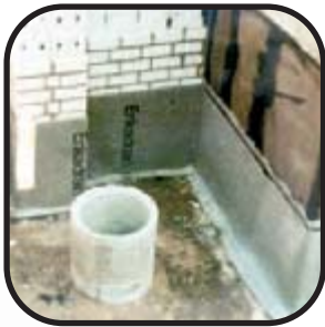
Dränung an Kellerwand
